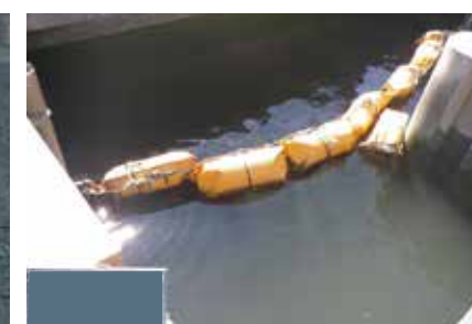
▲ オイルフェンス改修工事
